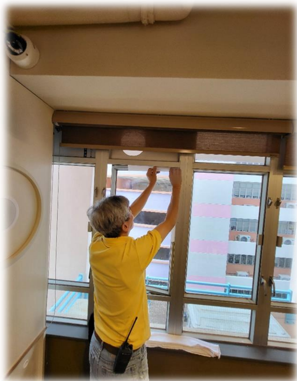
感謝工友們不辭勞苦，最早抵校，視察情況，疏通渠道，防止滲漏。
